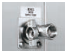
純水供給口(減圧弁付)
