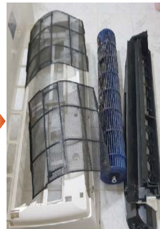
에어컨 작업 후
