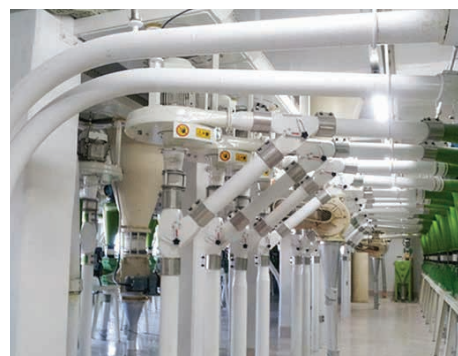
MJS EPDM + 내부스텐판 80~125A 한국. 밀가루 이송 시스템
