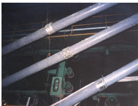
MJS EPDM 200A 한국. 펄프이송관, PVC파이프 주기적인 배관 내부 청소를 위해 커플링으로 파이프 연결
