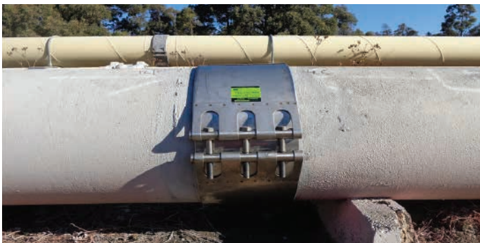
MJDL EPDM + 내부스텐판 507mm 호주. 화력발전소 재 슬러리 라인 유리섬유관 1km 기존 주철제 조인트의 잦은 누설로 당사 제품으로 교체 (610개)
