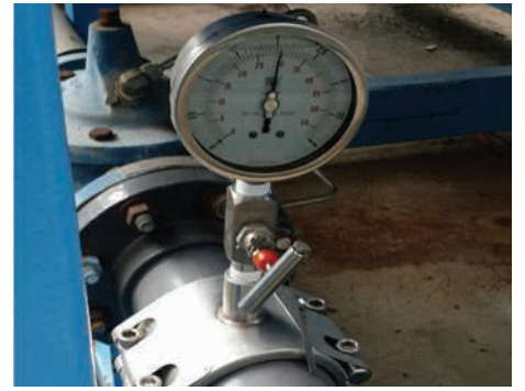
MJD-A EPDM 100mm 압력계 장착 태국. 발전소 급수관, PVC파이프
