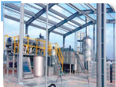
07 조립 및 시공
