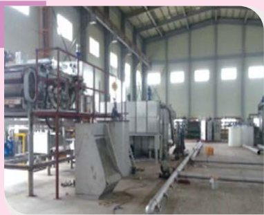
04 시공(자사 공장 내부)
