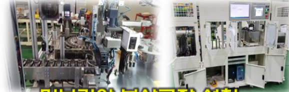
미보기어 부산공장 설치
